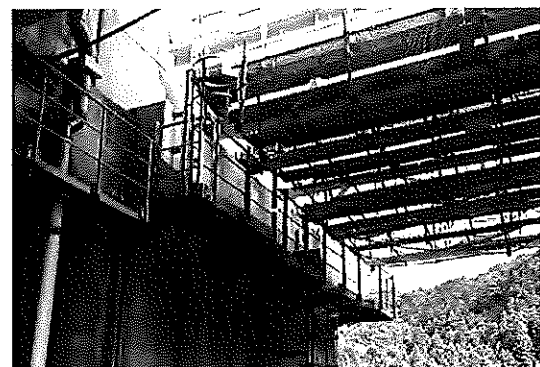
図-13 現地の設置状況
