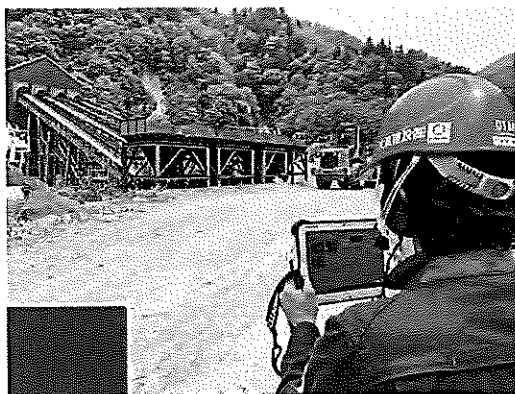
黒部奥山での遠隔臨場の様子 (写真③)
