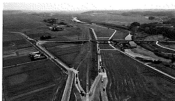
図-4 ダンプ運行状況全景
