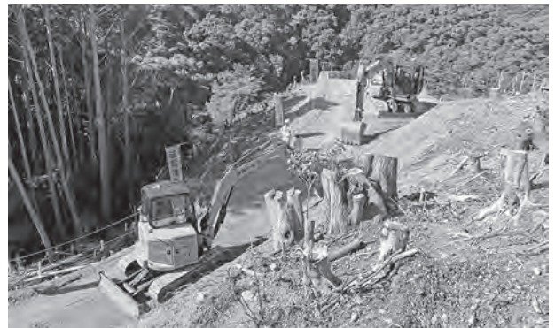
大小のICT建機による小規模工事
