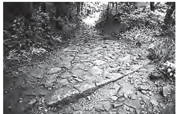
写真 箱根旧街道の石畳舗装 (注) 2
