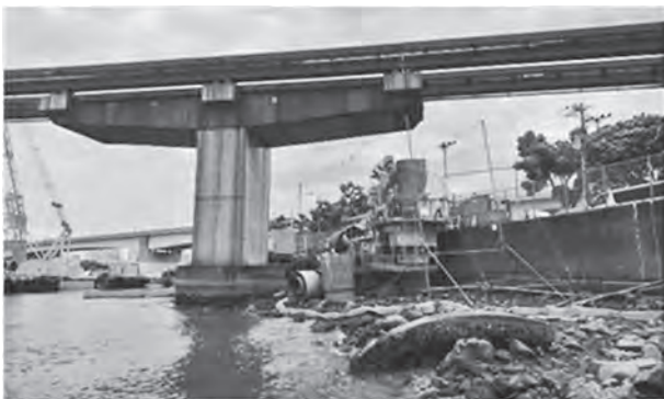
図-1 東京モノレール下での施工状況写真
