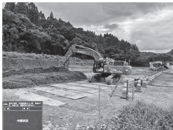
(写真-2) 地盤改良施工の様子
