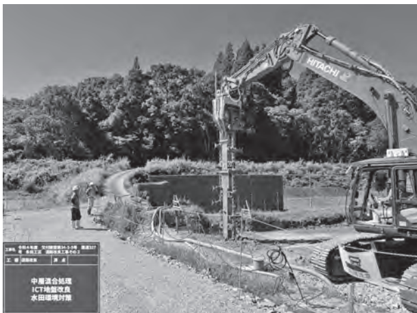
(写真-3) 飛散防止対策の様子
