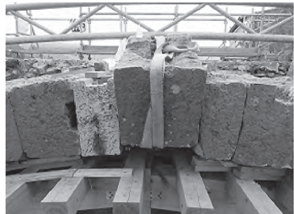
図-4 輪石組み2回目(下流側)
