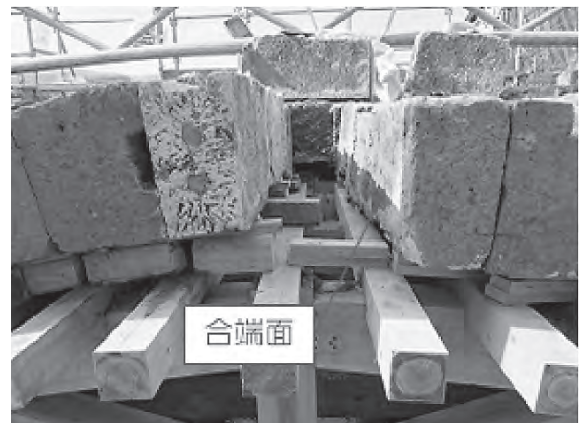
図-3 輪石組み1回目(下流側)
