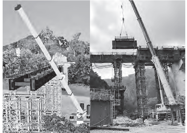
図-4 3次元モデルと実際の架設状況
