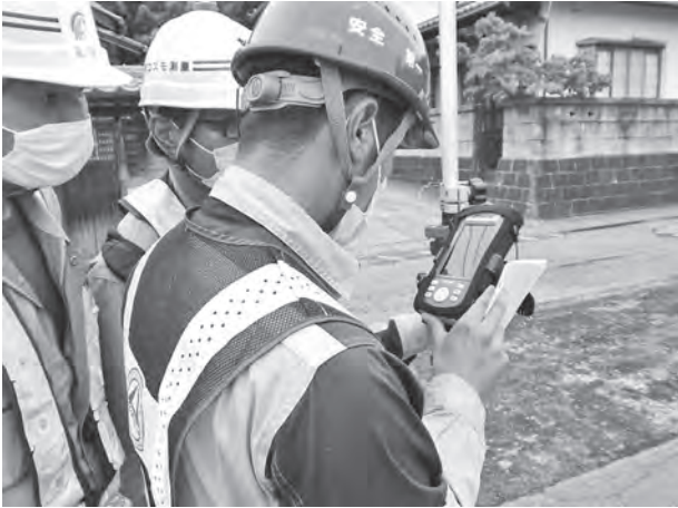
写真-8 切削後の出来形測定
