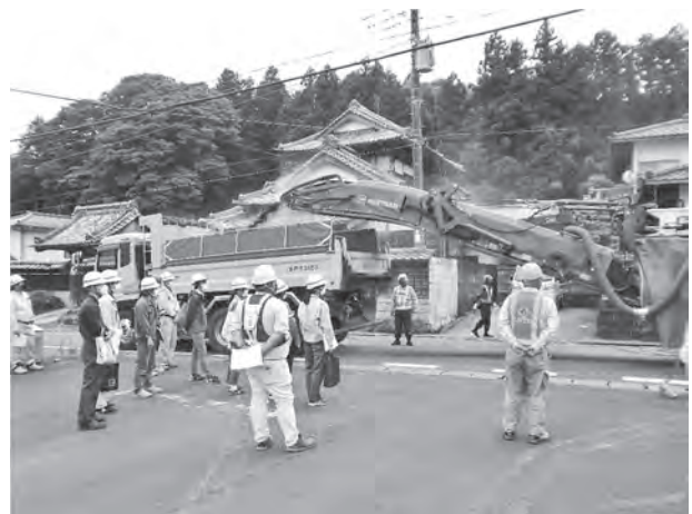
写真-7 MCアスファルト路面切削機の施工
