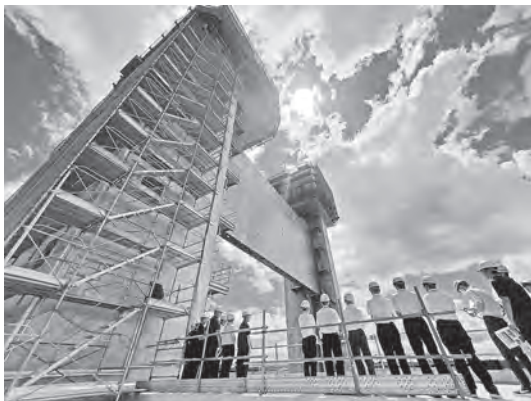
写真-1 現場見学会の実施状況
