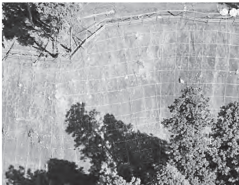
図-6 PPロープによる芯だし作業
