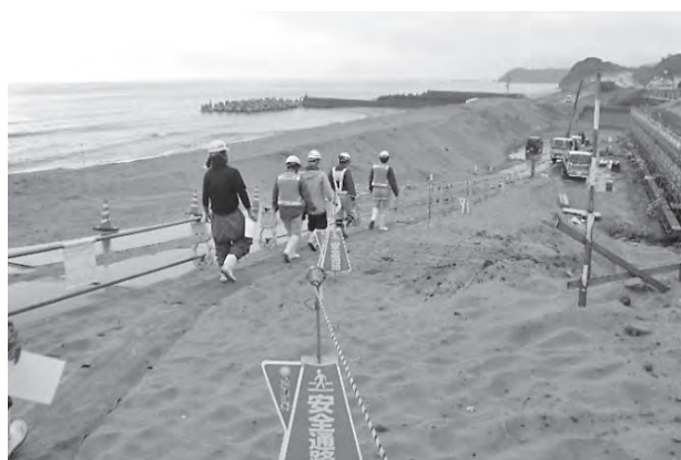
砂上に移動通路設置
