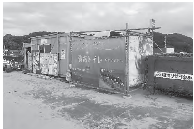
目隠しスクリーン設置
