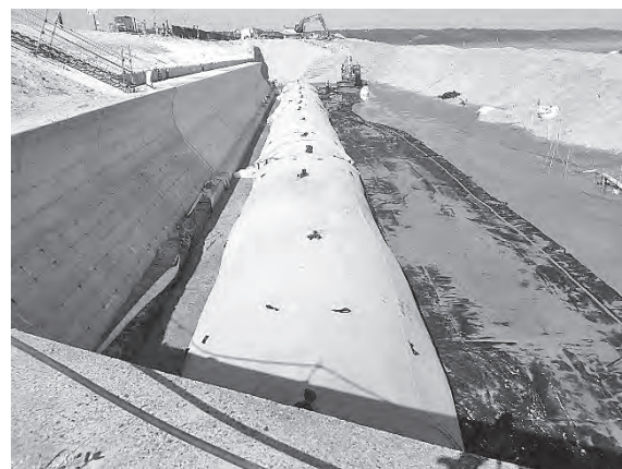
サンドバック施工状況
