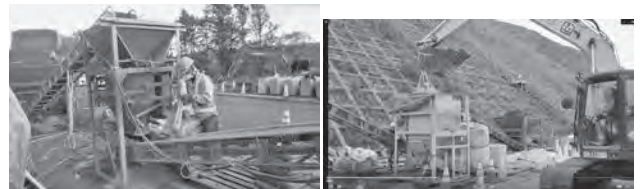
左は人力作業、右が簡易セメントサイロ
