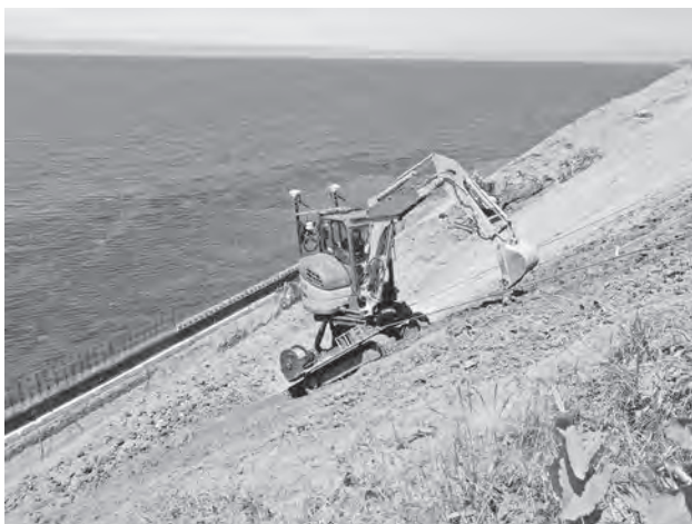
ICT施工状況
