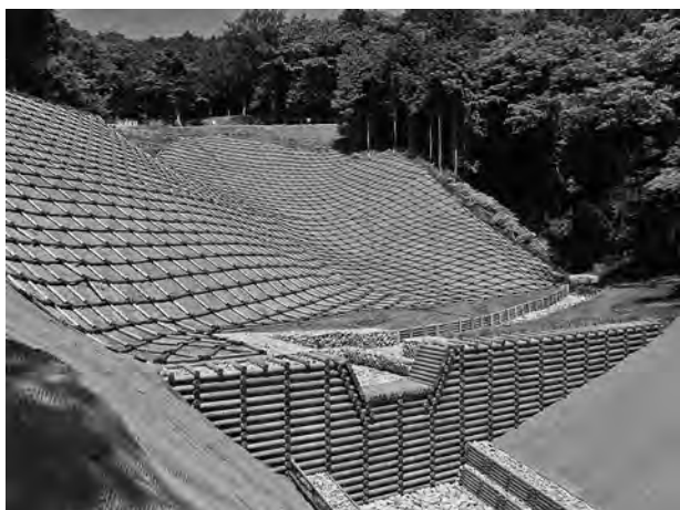
(写真-10) 校倉式土留工と丸太法枠工
