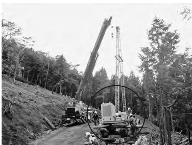
（写真－7）集材機（ウインチ）据え付け
