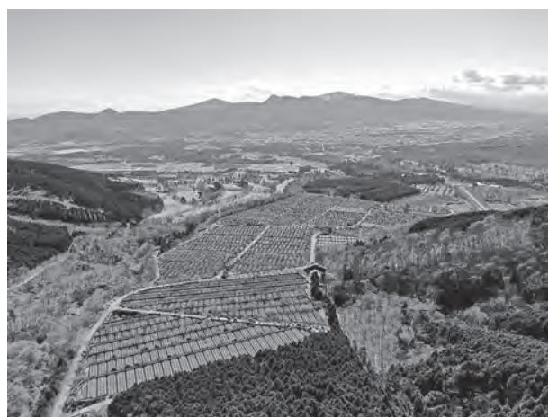
(写真-2) 現場下流部保安物件 (富士霊園、富士スピードウェイ、住宅地)
