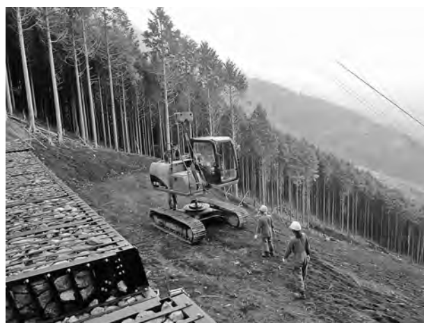
（写真－9）重機組立状況 （ケーブルクレーンを使用し施工箇所で組立）
