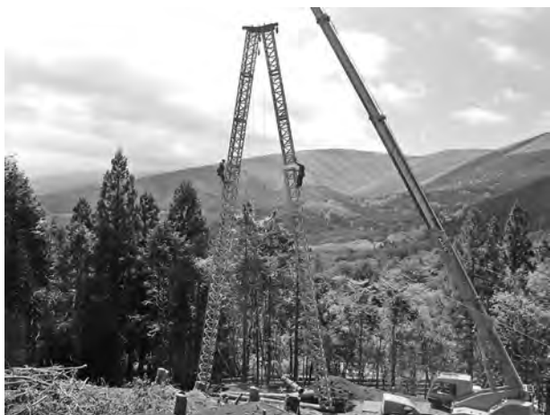
（写真－6）上部下部支柱建て込み H=24.0m （崩壊地縦断勾配により支柱高は変化）
