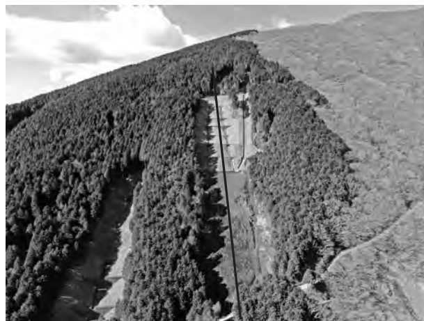
（写真－4）崩壊地② 継続工事で上部より施工中 黒線はケーブルクレーン法線
