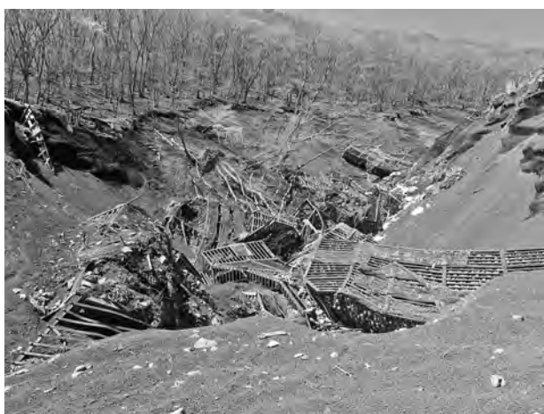
（写真－3）崩壊地① 土石流の発生が多い （下写真は土石流により崩壊した既設構造物）
