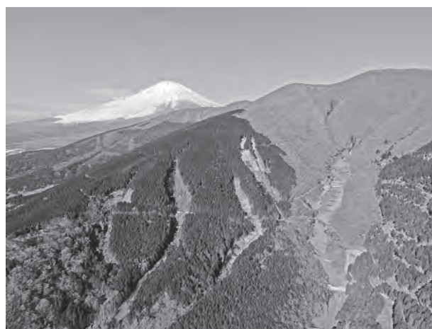
(写真-1) 事業体の一部、角取山地区を施工中
