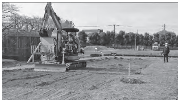
写真-1 排土板MC機能付小型バックホウ
