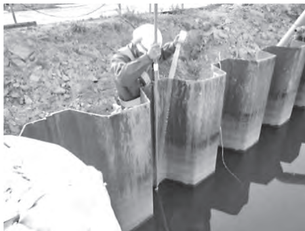
図-3 スズランテープ施工
