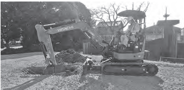
写真-2 丁張りレス施工
