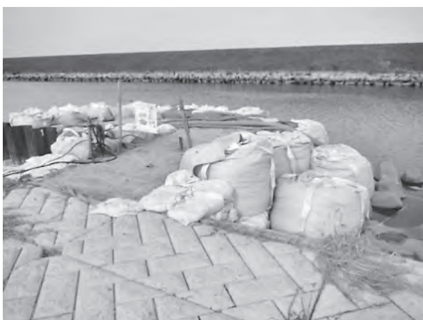
図-2 大型土のうによる仮締め切り
