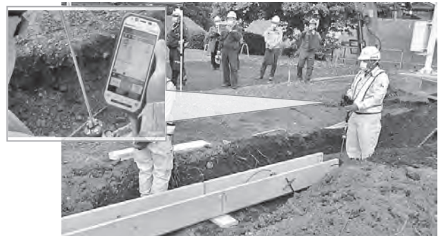
写真-3 プリズムによる構造物位置確認
