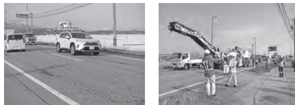
写真-1 MMS計測と切削状況
