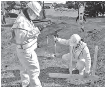
写真-4 TS+データコレクタを用いた丁張り設置
