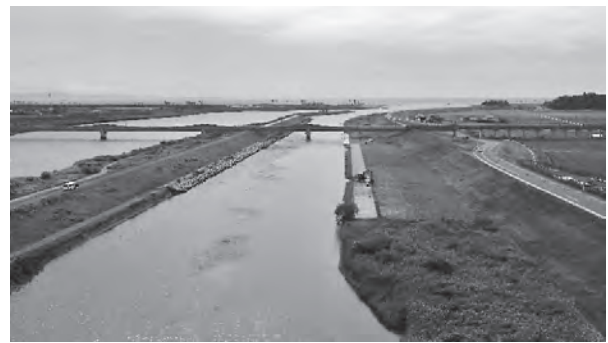
図-1 現場全景写真
