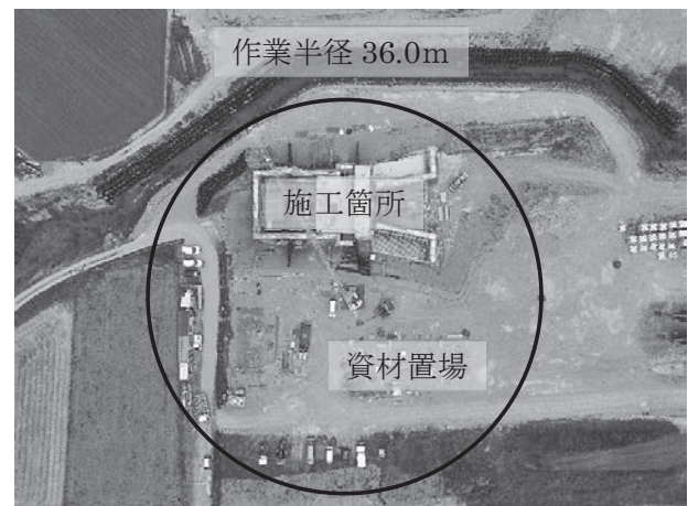
写真-3 定置式水平ジブクレーンの設置位置(著者撮影)
