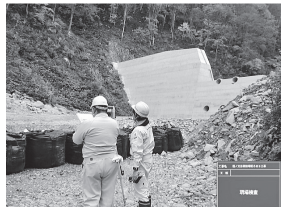
図-5 ノンプリズムTSでの確認
