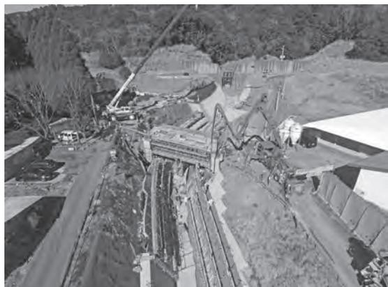
写真-1 下流より擁壁工・上部工・擁壁工を施工中
