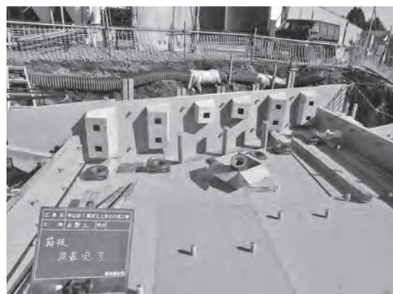
写真-2 箱抜き設置完了
