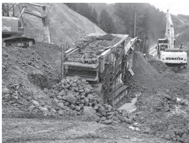
写真-7 ふるい分け作業状況
