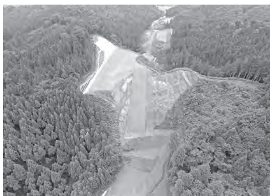
写真-2 2019年8月頃 本工事着工前
