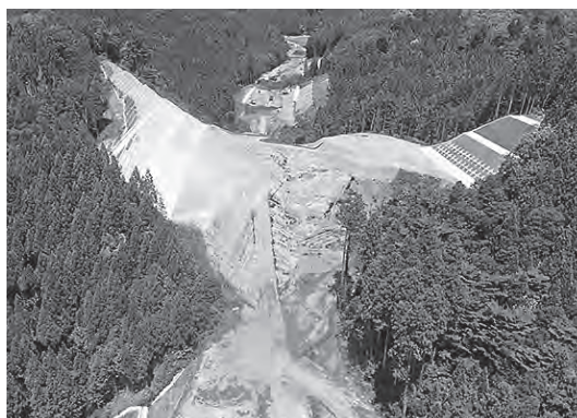
写真-3 2020年8月頃 本工事完成時
