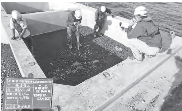
写真-5 中詰材均し出来形確認 (海上)
