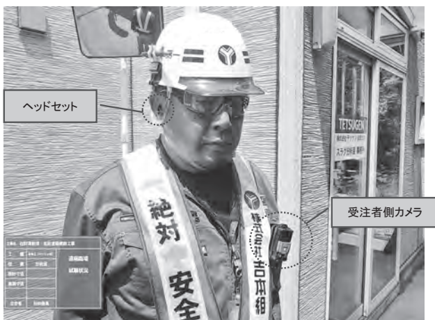
写真-2 撮影用機器装着状況
