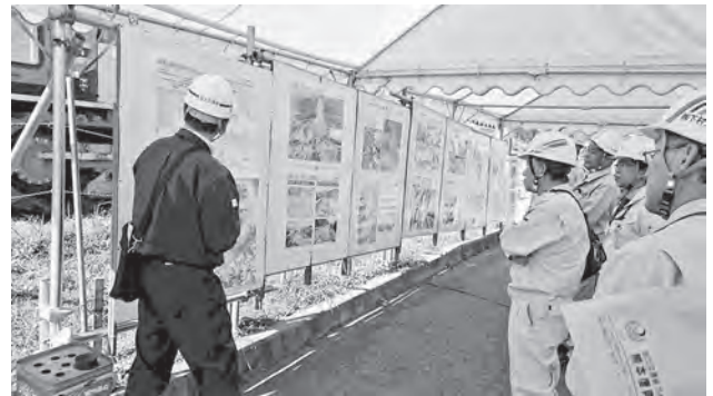
崩落現場復旧工事説明
