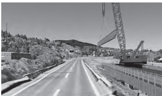
図-11 クレーン配置による安全性の確認
