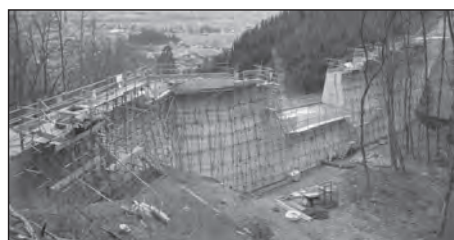
図-5 堤体背面作業通路兼作業足場
