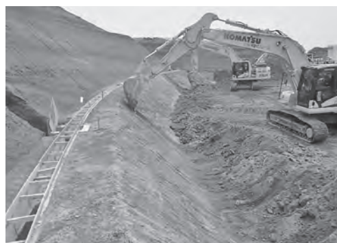
図－8 ICT建機による凹部のカーブ掘削
