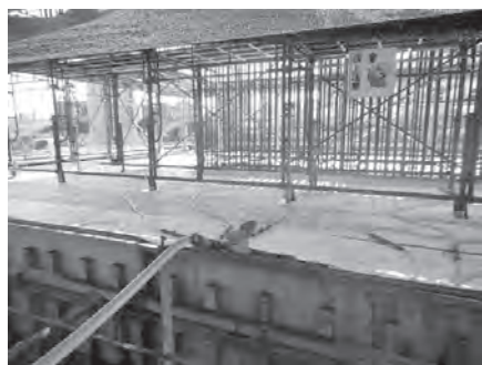
図-10 湛水養生状況
