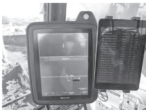
図－5 ICT切土・積込併用機モニター
