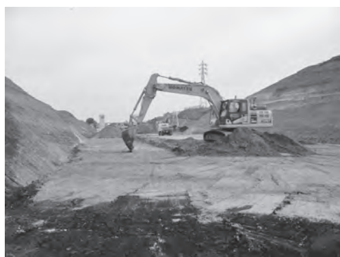
図－6 ICT建機による床付作業
