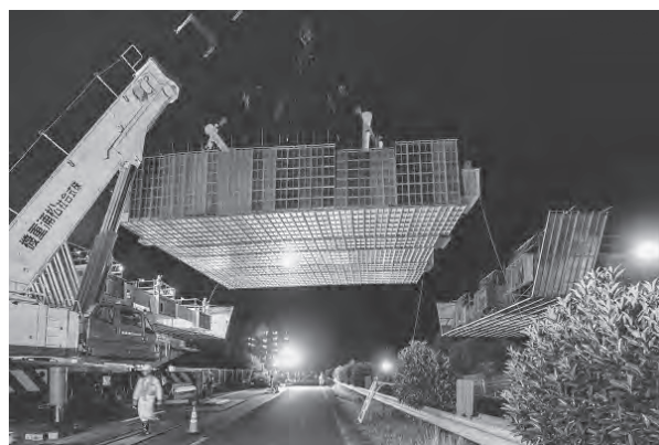
図-5 夜間一括架設状況
