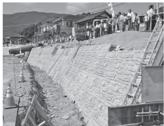
<野呂川護岸復旧工事状況>
