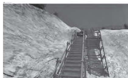
図-4 安全点検箇所の確認
