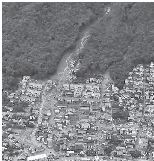
<被災後の303溪流の状況>
