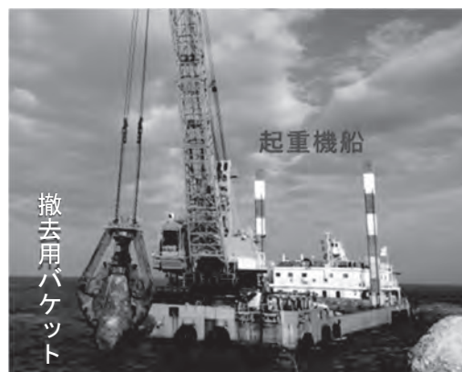
図－2 ブロック撤去状況
