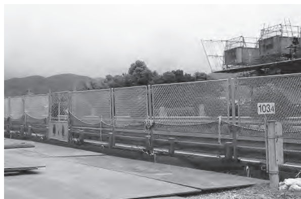
図-7 H鋼ガードレール+防護フェンス
