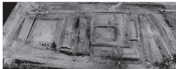
図-2 施工前の状況（3次元起工測量）
