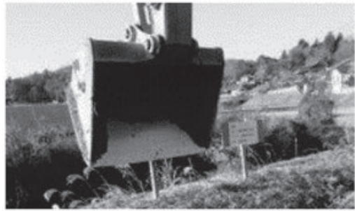
図-9 作業前ごとの精度確認状況
