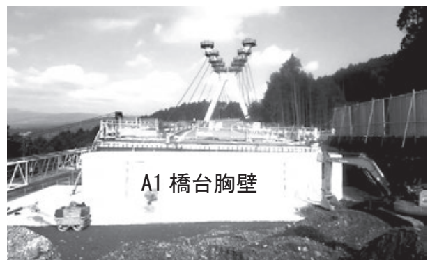
図-11 ⑧胸壁再構築
