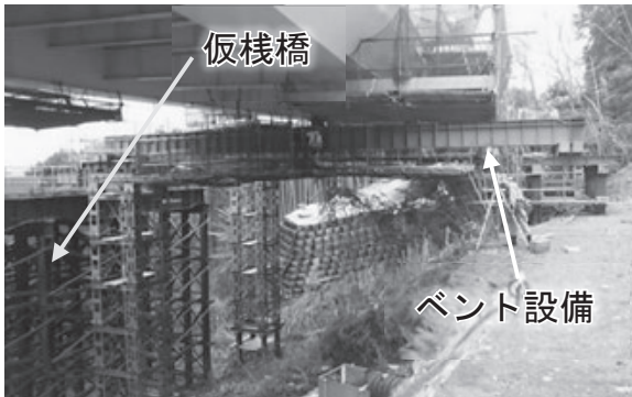
図-6 ①仮栈橋と②ベント設備
