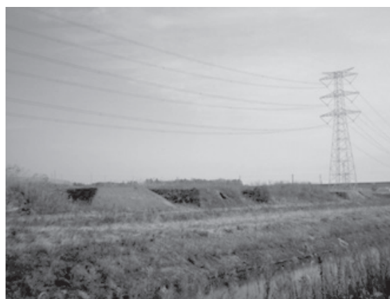
図-1 施工前の状況
