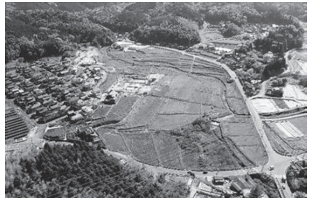
図-1 本工事現場の空中写真（着工前）
