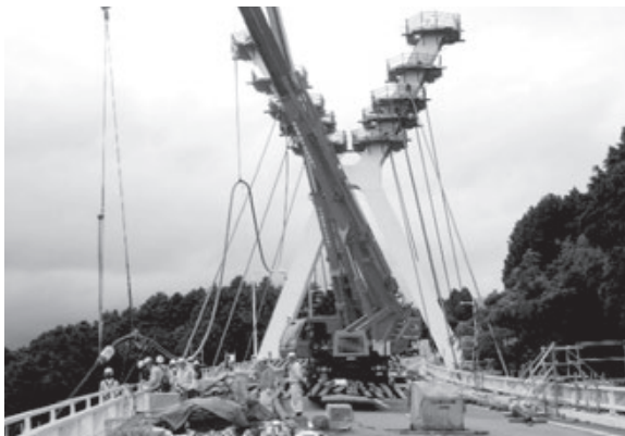
図-8 ⑦斜ケーブル撤去状況
