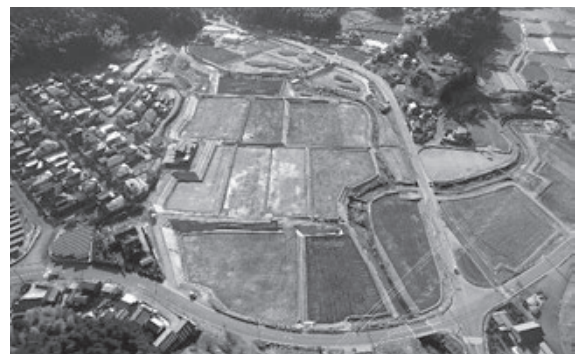
図-12 本工事現場の空中写真（施工後）
