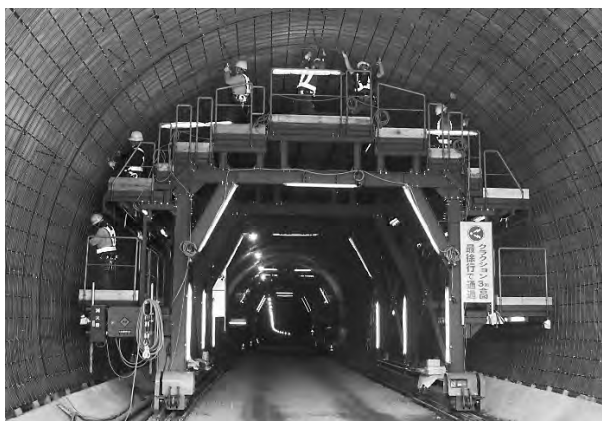
図-11 風管スペースのない鉄筋組立台車で作業状況
