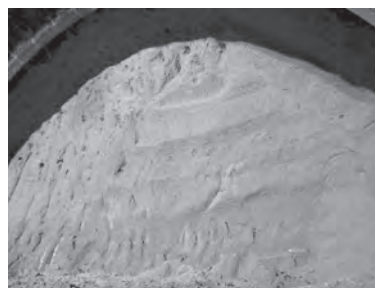
図-2 切羽地質状況(壮瞥火砕流堆積物)
