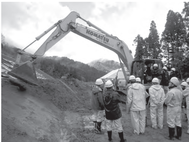
法面整形操縦状況
