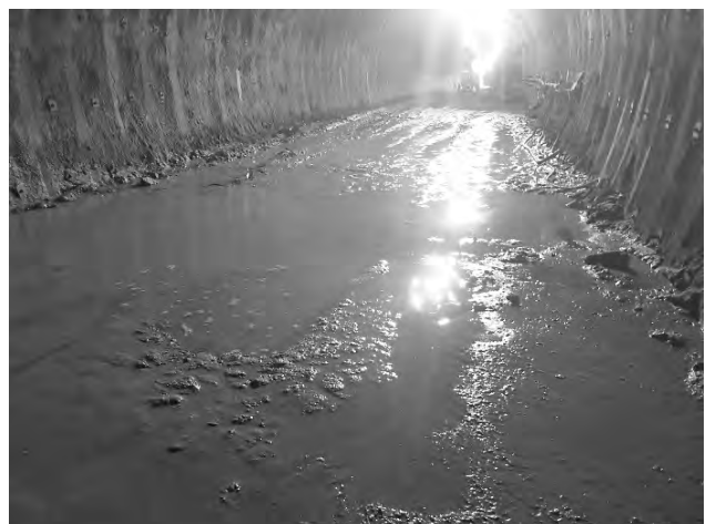
図-5 湧水による泥濁化
