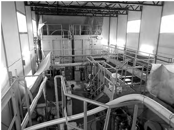
図-7 大型貯水槽設置 (20m 3 ・2基)
