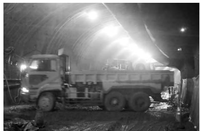
図-10 拡幅帯でのダンプ転回状況
