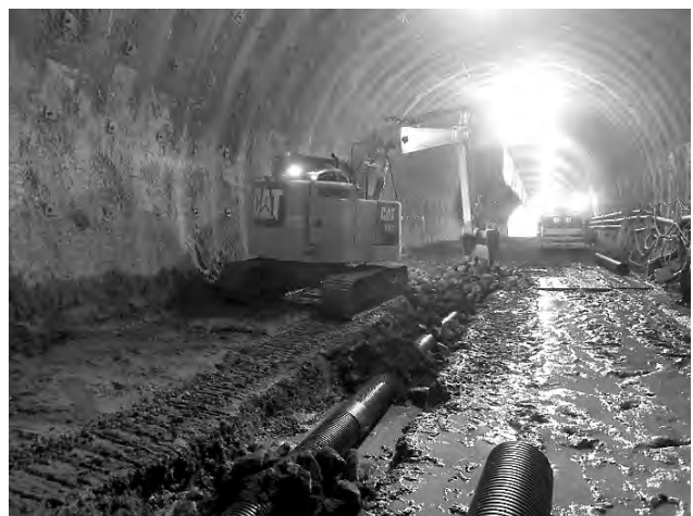
図-6 インバート下中央排水の施工
