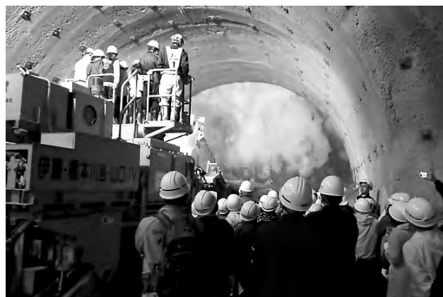
図-12 現場見学会の様子（掘削状況）
