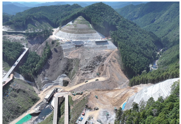
写真-3 ダム本体部 (R7.9)
