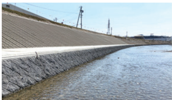
写真-3 低炭素型コンクリート製品活用モデル工事
