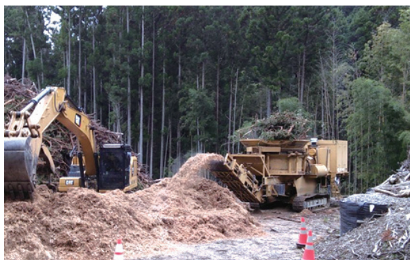
写真-13 破碎機によるチップ化作業
