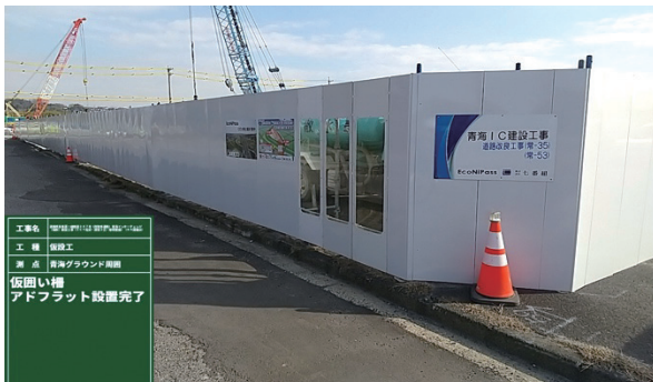
写真5 フラットパネル仮囲い
