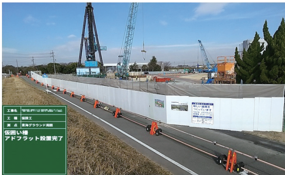
写真3 フラットパネル仮囲い
