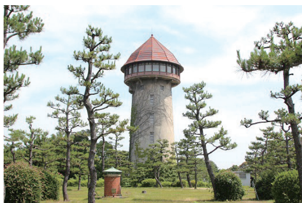
(写真2) 東山給水塔
