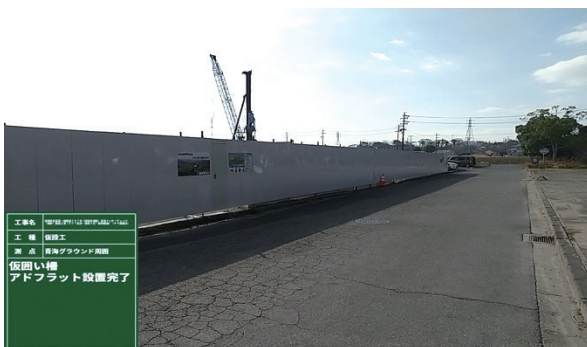
写真4 フラットパネル仮囲い
