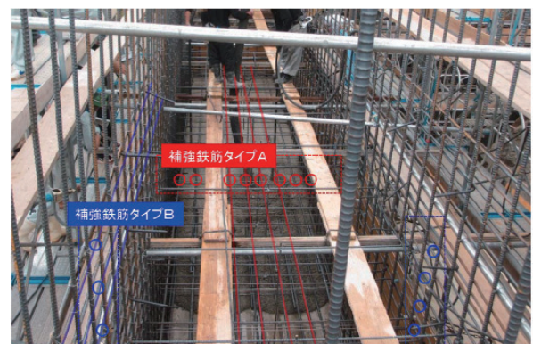
写真17 補強鉄筋配置
