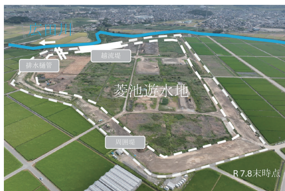
写真-2 菱池遊水地（整備中）
