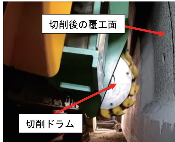
写真-1 切削試験状況
