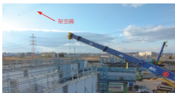
写真-1 主桁架設状況
