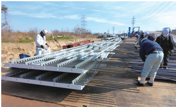
写真-4 鉄筋挿入状況
