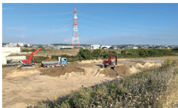
写真-2 ヤード掘削状況
