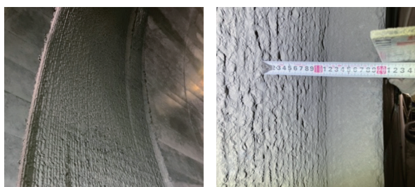
写真-2 切削後の覆工面と切削深さ計測状況
