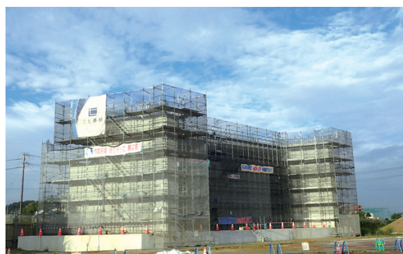
写真 21 完成（足場あり）
