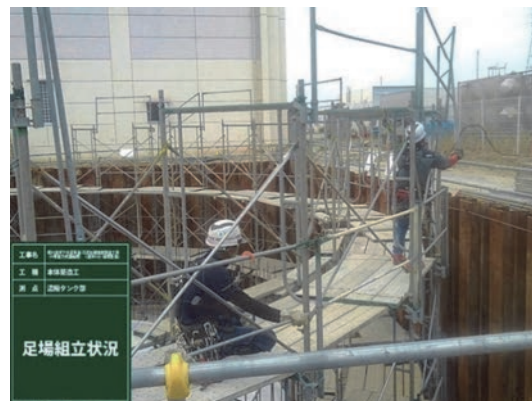
【足場組立て状況】
