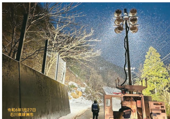
写真-2 土砂撤去作業状況
