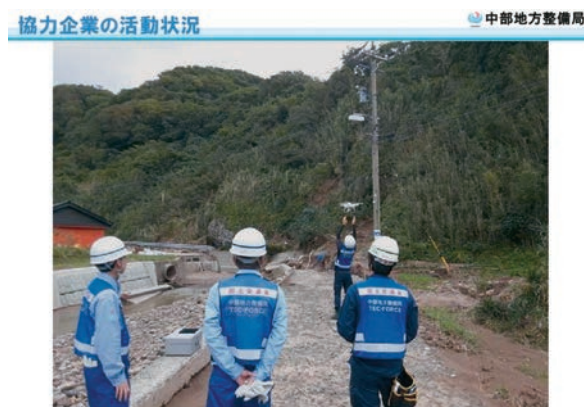
写真－9 ドローン調査の状況
