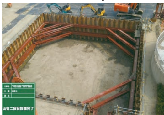
【山留め工完了全景】
