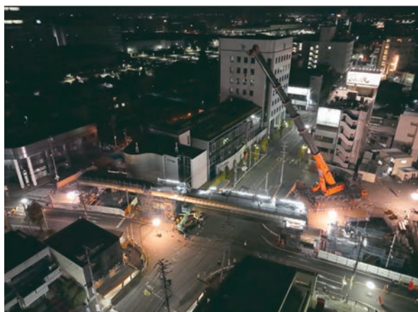
写真－1 交差点上架設状況
