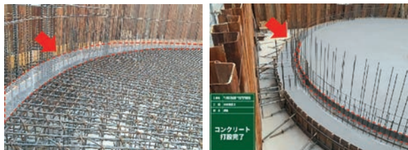
【ラス型枠設置完了】 【コンクリート打設完了】
