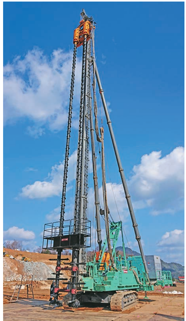
写真 2-1 CDM-EXCEED 工法施工機械
