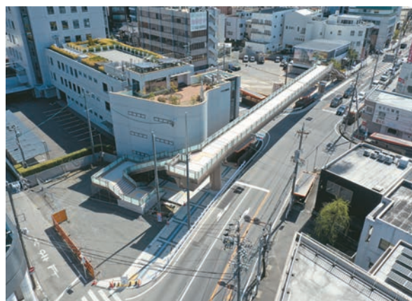
写真-6 全景写真1
