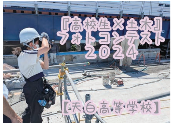
地元の高校生を工事現場に招いて撮影会を実施
