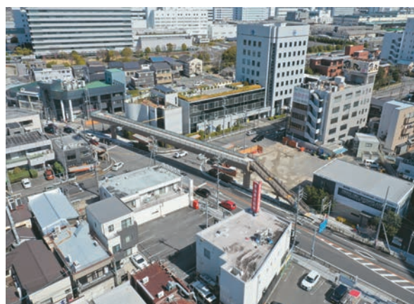
写真-7 全景写真2
