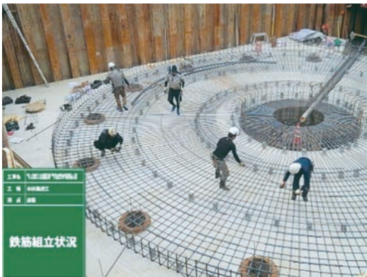
【底版鉄筋 加工組立状況】
