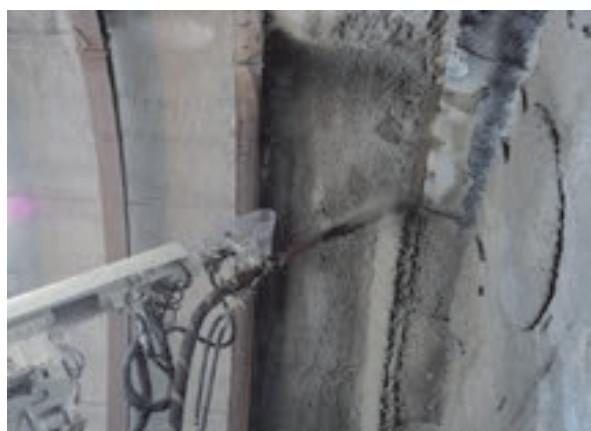
図5 自動吹付け機による支保工裏への吹付け
