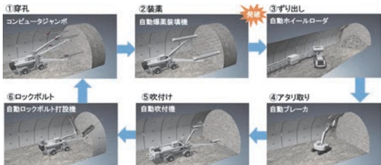
図8 「A<sup>4</sup>CSEL for Tunnel」 の自動化イメージ
