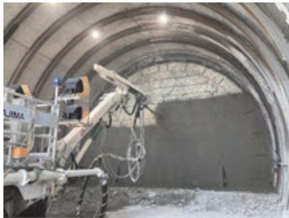
図4 自動吹付け機による切羽面の吹付け
