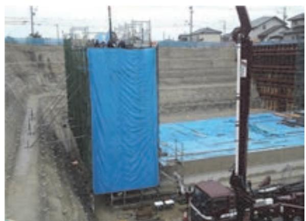
写真 11 温度低下防止対策 (シート + ヒーター)
