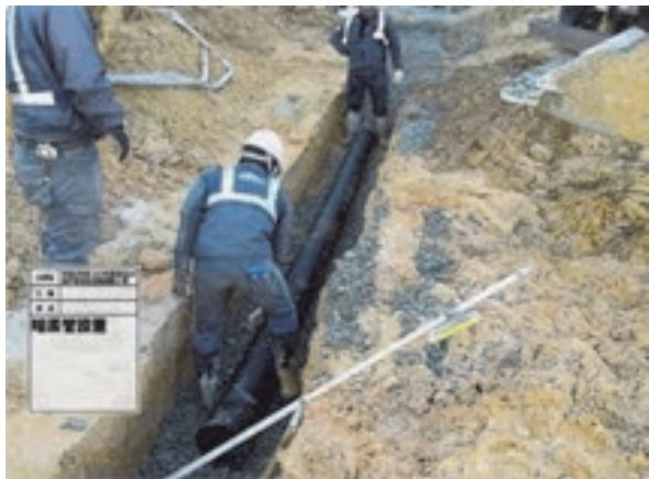
写真4 暗渠管設置
