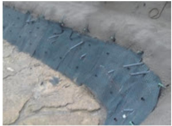
写真3 水抜きパイプ増設及び透水マット設置
