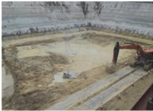
写真6 水中ポンプで汲み上げながら掘削
