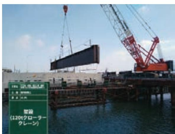
写真-3 クレーン架設状況
