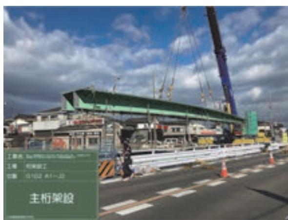
写真-2 主桁架設状況
