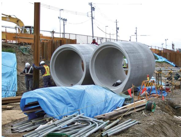
写真-7 φ1,800mmの雨水管
