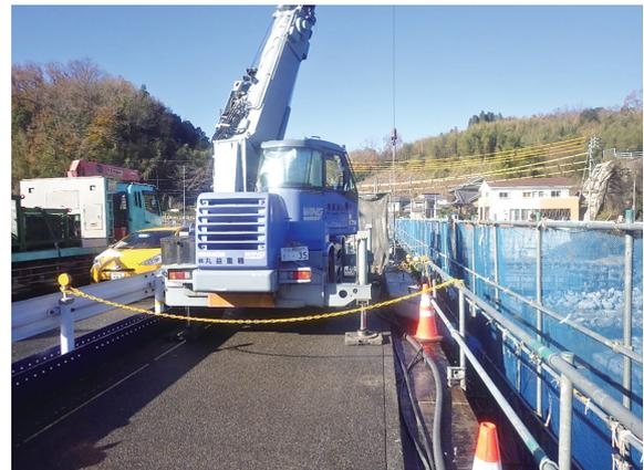
写真-2 橋面クレーン配置状況
