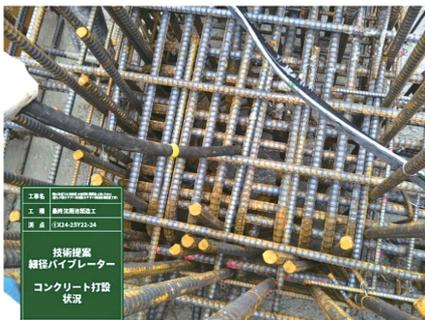
※直径28mmのフレキシブルバイブレーターで、締固め能力は従来の同径と比較し、約1.5倍
