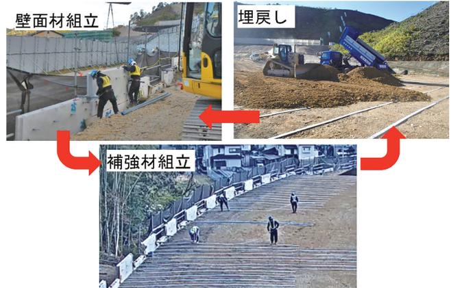
図-1 補強土壁工の施工サイクル
