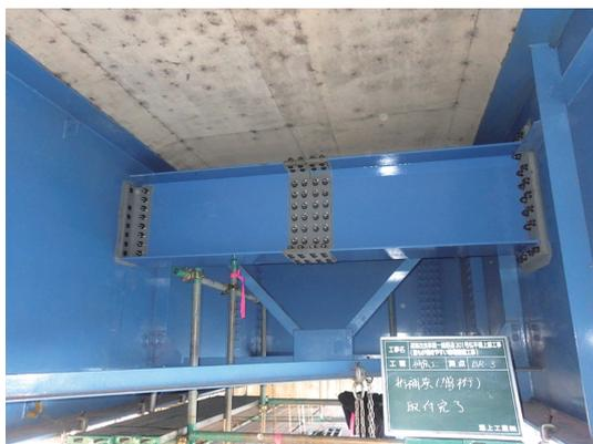
写真-5 増設桁(横桁) 設置完了
