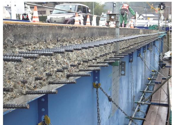
写真-3 切断後鉄筋ハツリ完了
