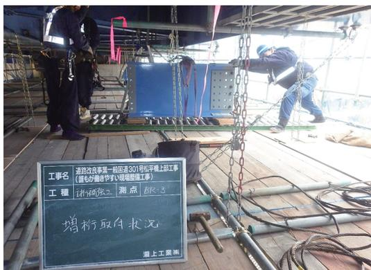
写真-4 横桁運搬状況
