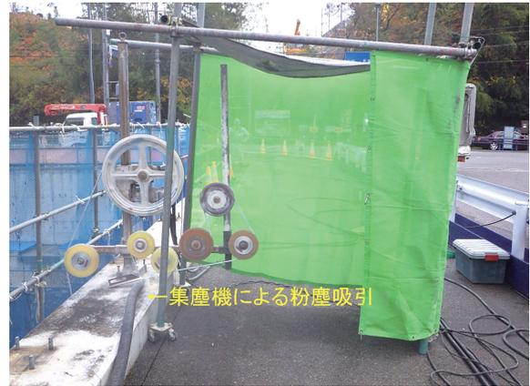
写真-1 ワイヤーソー切断状況
