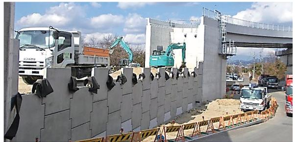
写真-4 補強土壁(CDランプ箇所)
