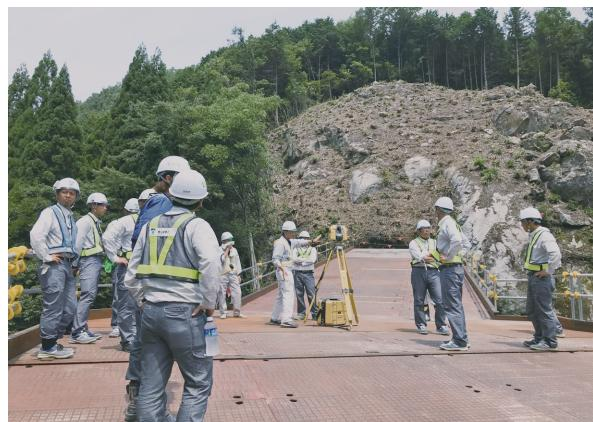
写真-4 三次元起工測量（レーザースキャナ）
