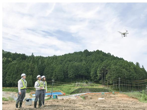
写真-6 自社社員によるUAVドローン三次元起工測量
