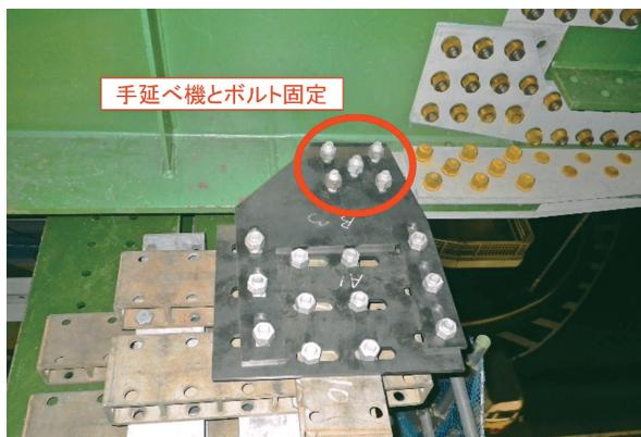
写真5 手延べ機ボルト固定状況
