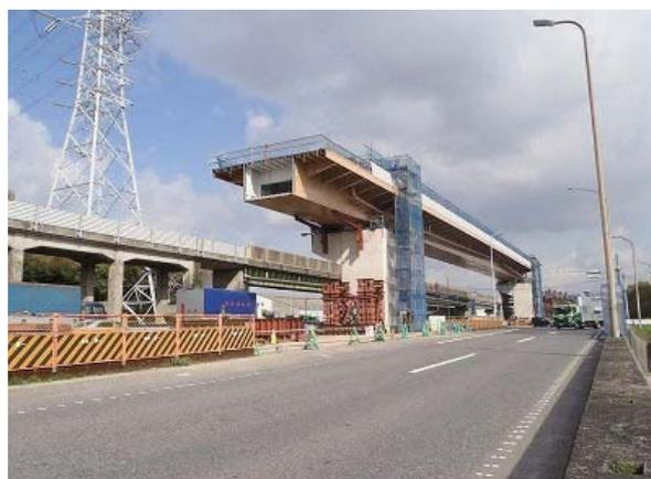
図-10 桁降下完了
