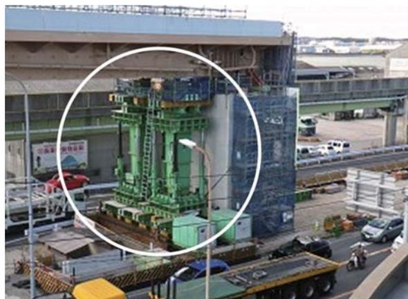
図-8 降下装置設置状況
