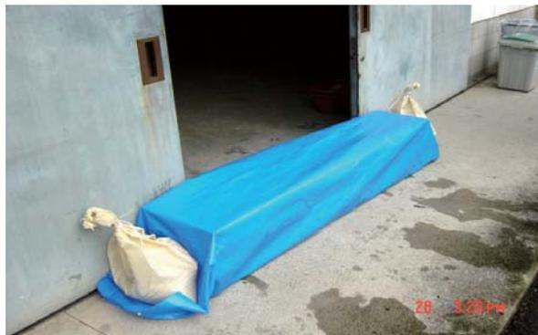
写真-3 簡易水防工法の設置状況
