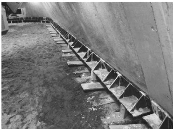
写真-1 付刃口設置状況
