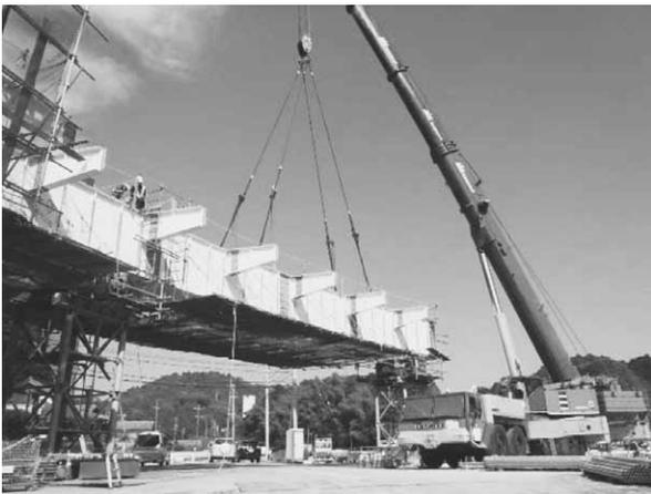
写真-1 折りたたみ式ベント設置状況
