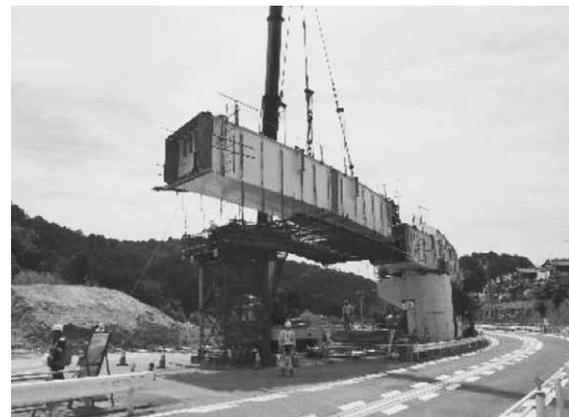
写真-4 急曲線部架設状況
