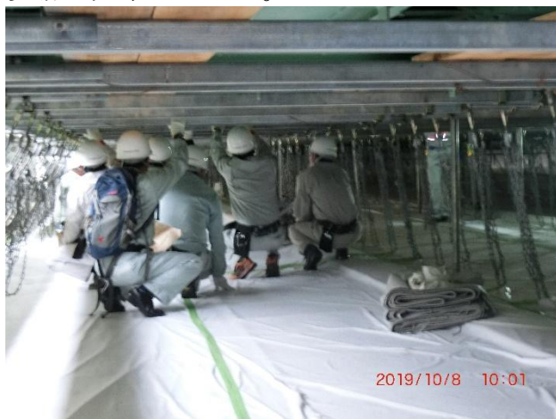
(床版吊り下げ足場内にて)
